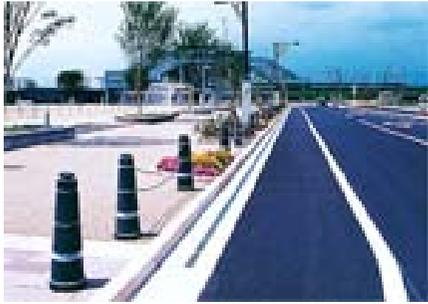
視覚障害者には多少の段差は境界線を知る目印として必要。車歩道の段差が2cmのセミフラット道路
